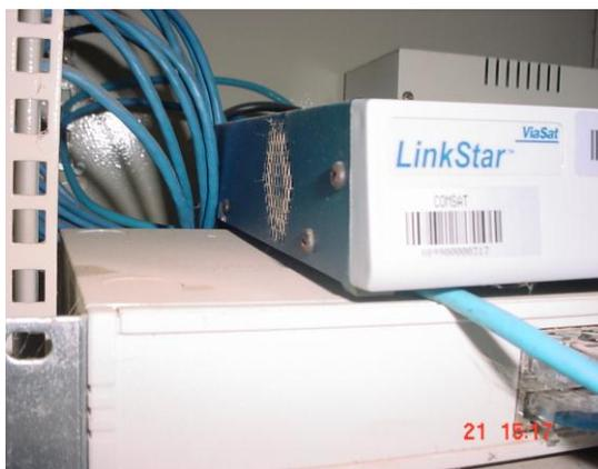
Foto 03: Hub da marca Link Star (Via Set), recebido em função do Programa GESAC, sem manutenção ou limpeza, coberto de poeira.
